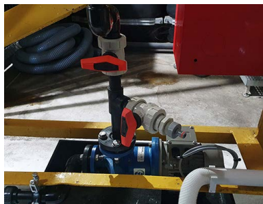
Fot. 8. Pompa transferowa do przepompowania czynnika roboczego ze zbiornika magazynowego do zbiornika technologicznego.
