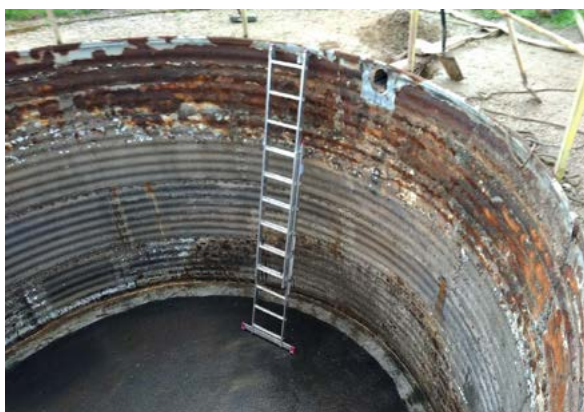
Fot. 3, 4. Stan stalowego osadnika wstępnego przed uszczelnieniem – widoczne zniszczenia zbiornika powodujące przeciek ścieków do gruntu
