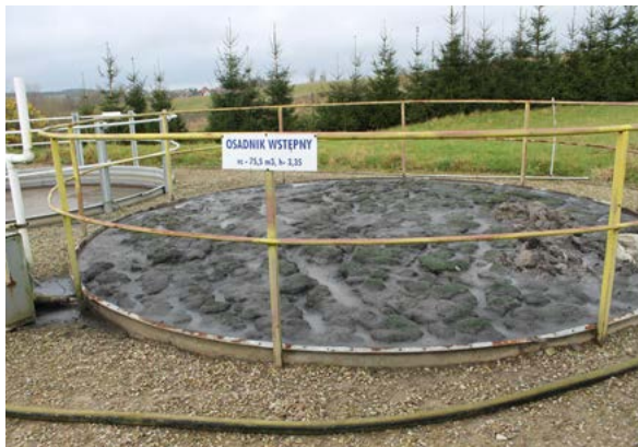
Fot. 1, 2. Osadnik wstępny przed renowacją – napełniony i opróżniony (tuż przed wykonaniem prac).
