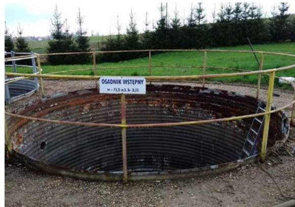
Fot. 1, 2. Osadnik wstępny przed renowacją – napełniony i opróżniony (tuż przed wykonaniem prac).
