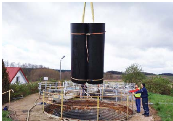
Fot. 5, 6, 7. Prace montażowe w ramach uszczelnienia zbiornika na ścieki.
