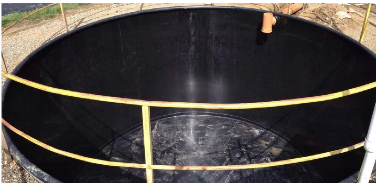
Fot. 8. Osadnik wstępny wyłożony wykładziną chemoodporną z tworzywa PEHD.
