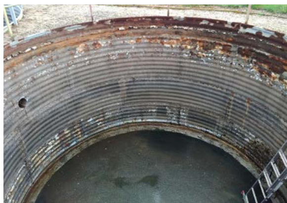
Fot. 3, 4. Stan stalowego osadnika wstępnego przed uszczelnieniem – widoczne zniszczenia zbiornika powodujące przeciek ścieków do gruntu
