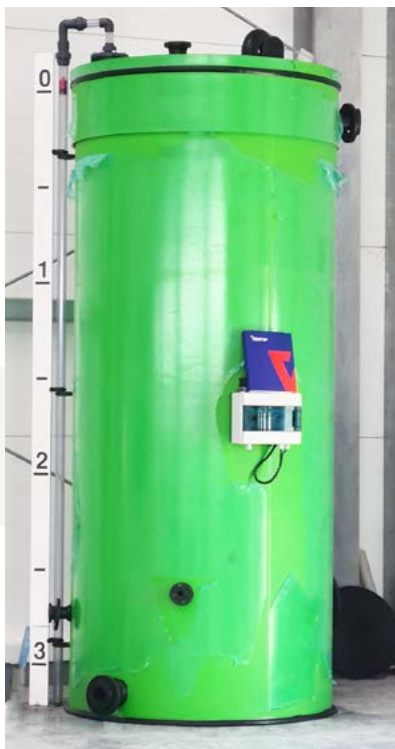
Zbiornik buforowy wody DEMI o pojemności całkowitej 3,6 m 3 dla nowoprojektowanej instalacji oczyszczania gazów procesowych (płukania i mgławienia).
